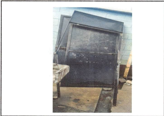
Foto 1: Reparación de Puertas
