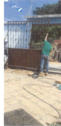
Foto 2: Mejoramiento e instalación de Porton
