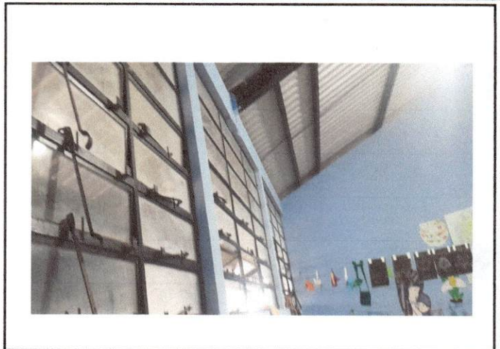
Foto 2: Reparación de Ventanas
