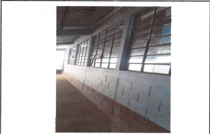
Foto 3: Reparación de Ventanas
